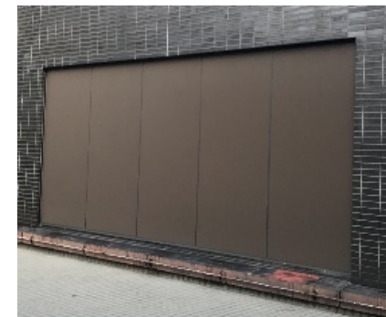
(左図：被災したパティオの大型ガラス、右図：アルミ製にして修繕)
